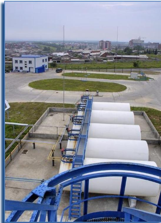
Пример железобетонного обвалования резервуаров
